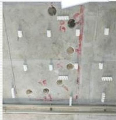
图4 分电器底盒固定位置粘胶示例
