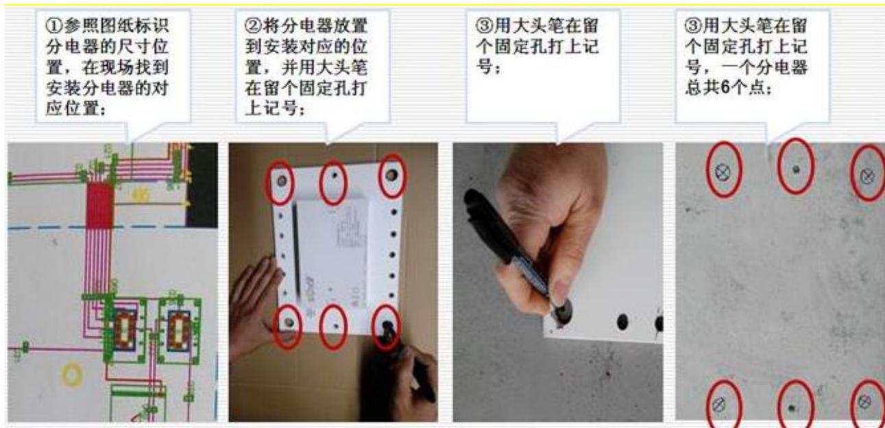
图3-2 分电器底盒的定位示例
