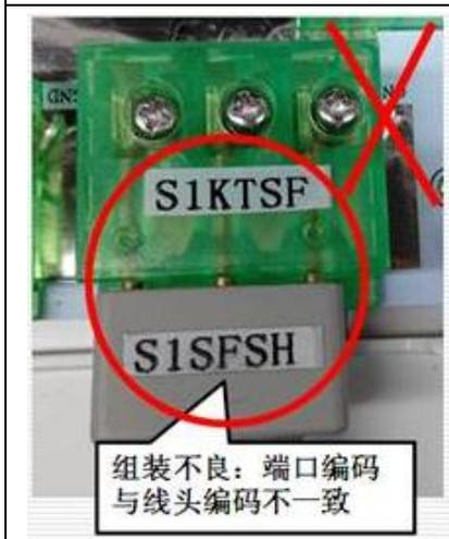
图13-3 检查插座分电器端口标签与线头标签是否一致示例
