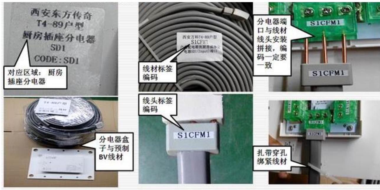
图6-1 插座分电器底盒安装示例
