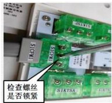
图13-7 检查插座分电器端口螺丝是否锁紧的示例
