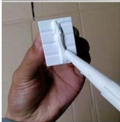
②对应记号点位粘上吊钩，稍微用力挤压使吊钩与墙面充分粘贴；
