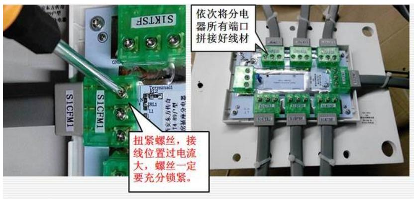
图8 插座分电器端口锁紧螺丝示例
