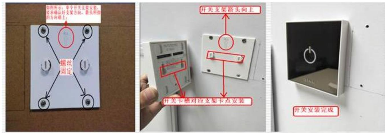
图10-1 区域单个无线开关安装示例
