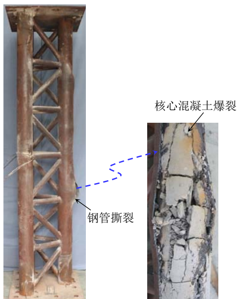
图 7.0.7-1 火灾下桁式钢管混凝土构件弦杆钢管撕裂和核心混凝土爆裂
