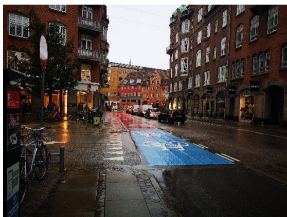
图 5.2.5 社区级道路与城市支路交叉口处用彩色铺装予以提示，丹麦哥本哈根
