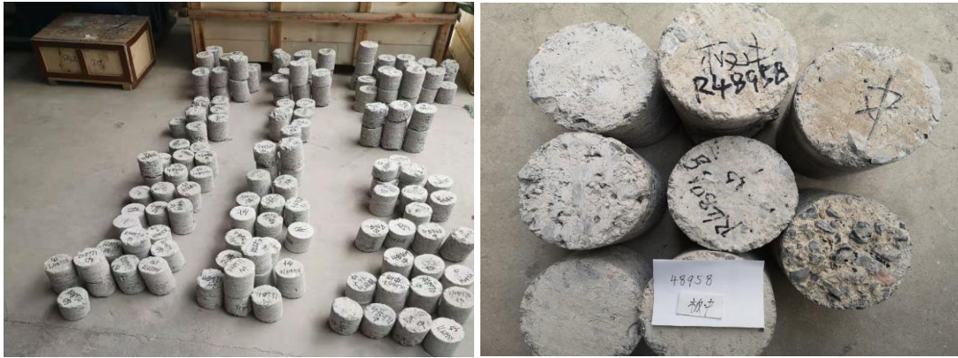
说明图 4.1.1 服役高速铁路道床混凝土粉化取芯
